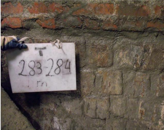
Gereinigtes und verfugtes Schachtmauerwerk
