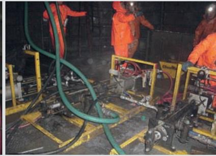
Abb. Mitte: Verpressarmatur für chemisches Abdichtungsmittel „NOH20“
