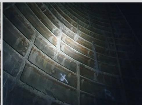
Das Injektionsmittel wirkt, die Tübbinge trocknen ab
