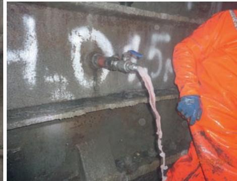
Abb. links: Mitarbeiter bei Verpressarbeiten im Vorschacht
