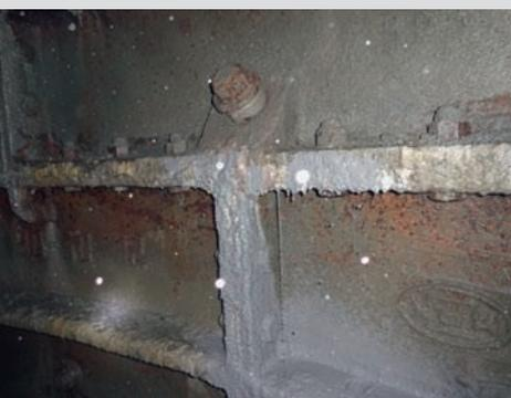
Druckhafter Austritt von chemischem Injektionsmittel an einer Tübbingfuge
