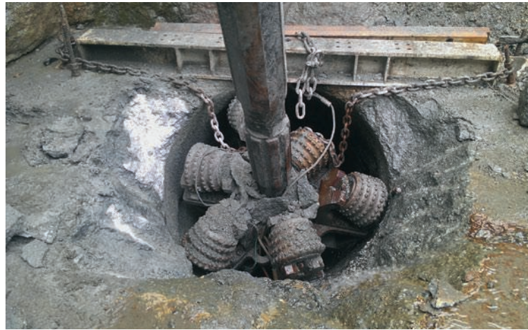
Erfolgreicher Durchschlag des Raisebohrkopfes
