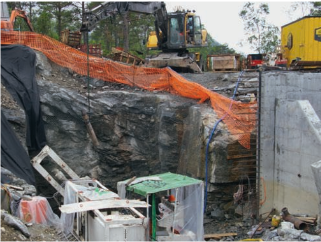
Einheben einer Raisebohrstange
