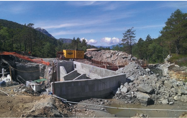
Baustelle Torsnes, Oberbecken und Einlaufbauwerk
