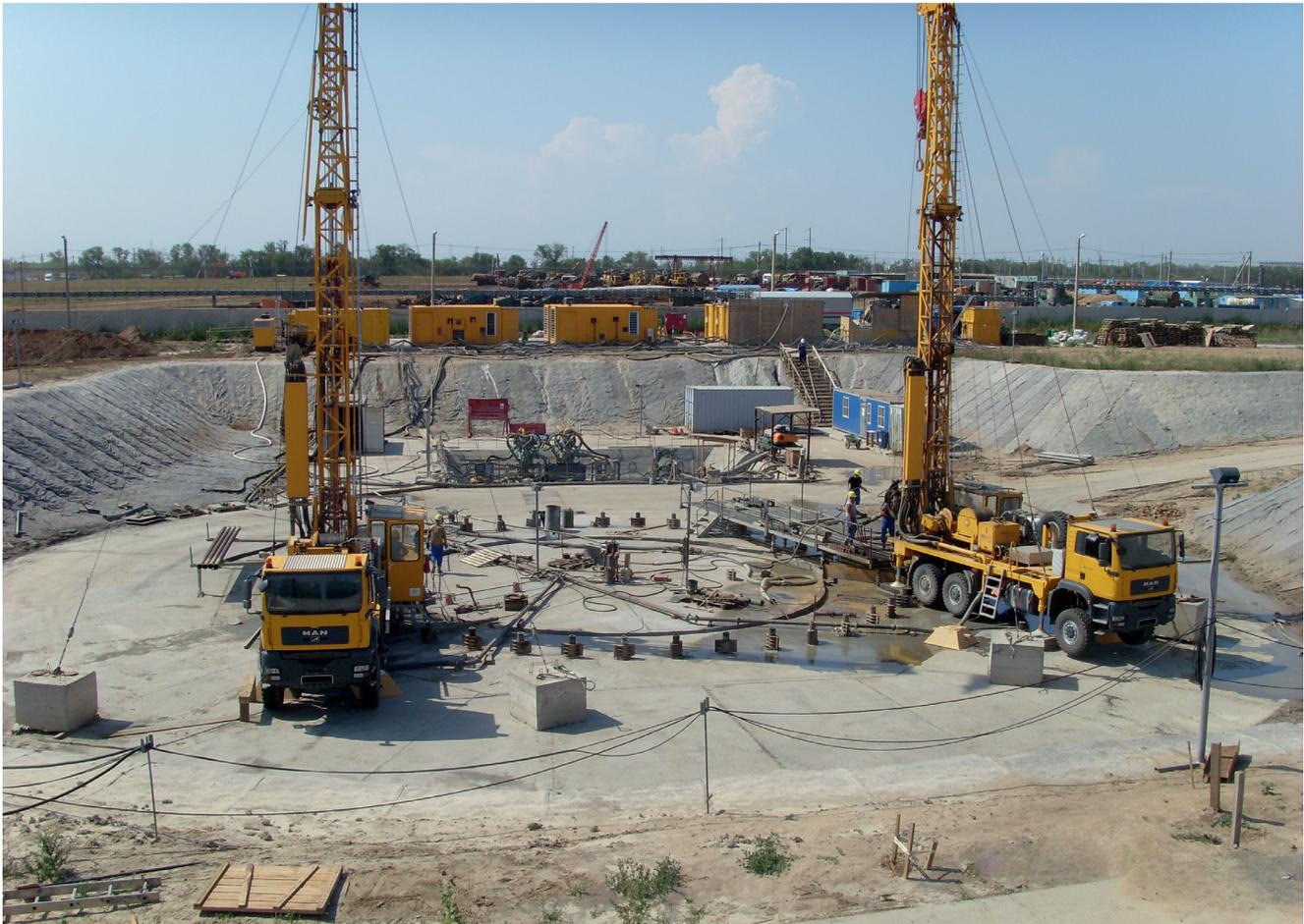
Einsatz der beiden Bohranlagen RB50 beim Bohren der Gefrierlöcher
