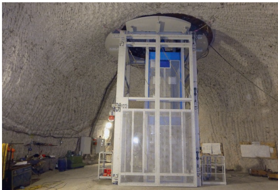
Schachtstuhl auf der 750-m-Sohle, Ansicht von Südwesten auf das Großsteiltor
