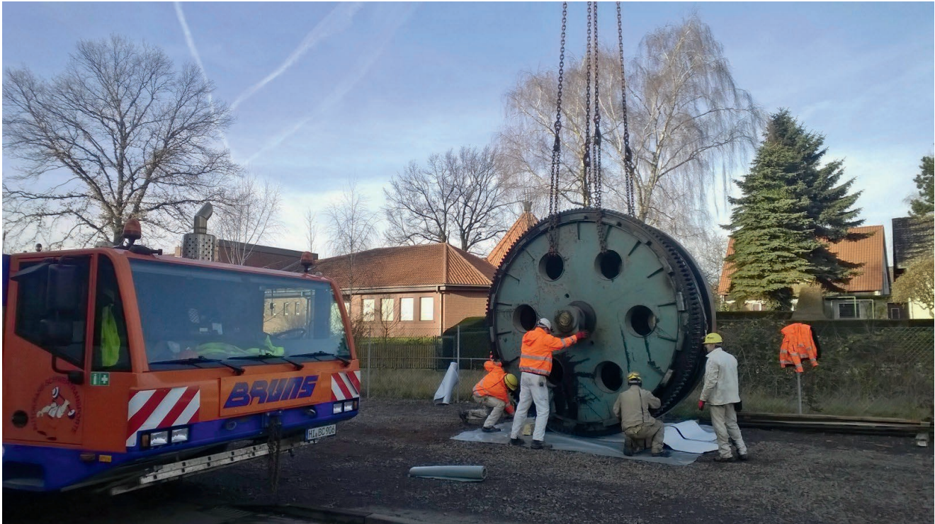
Demontage der alten Fördermaschinentrommel
