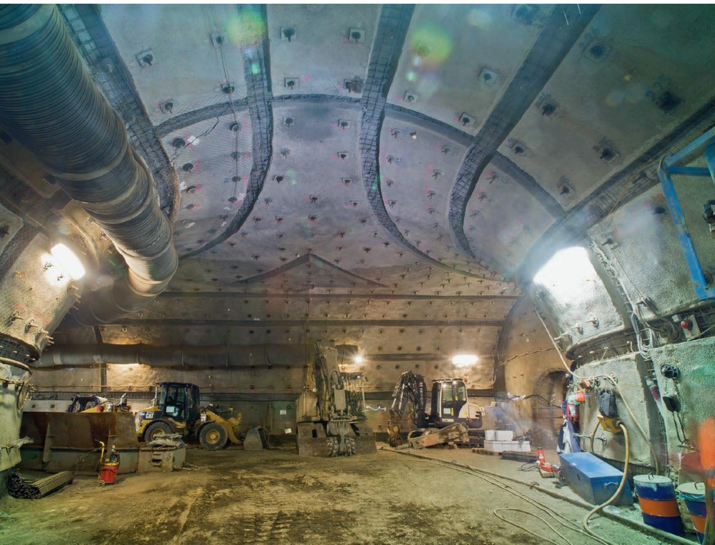
Geschlitzter Spritzbetonausbau mit Systemankerung
