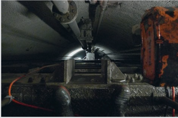
Abb. oben links: Montage der Betonfalleitung
