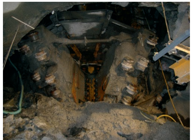
Durchschlag der Schachtbohrung mit der Schachtbohrmaschine VSB VI
