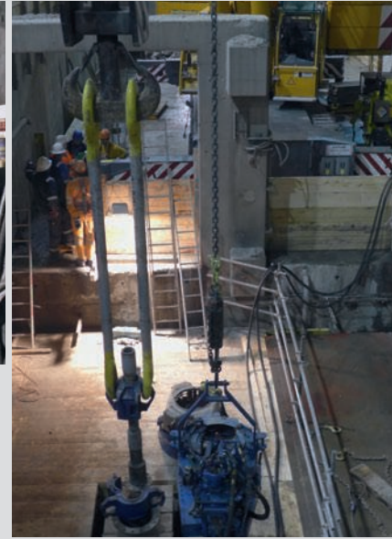
Abb. rechts: Demontage von API Rohr- leitungen im Schacht 1
