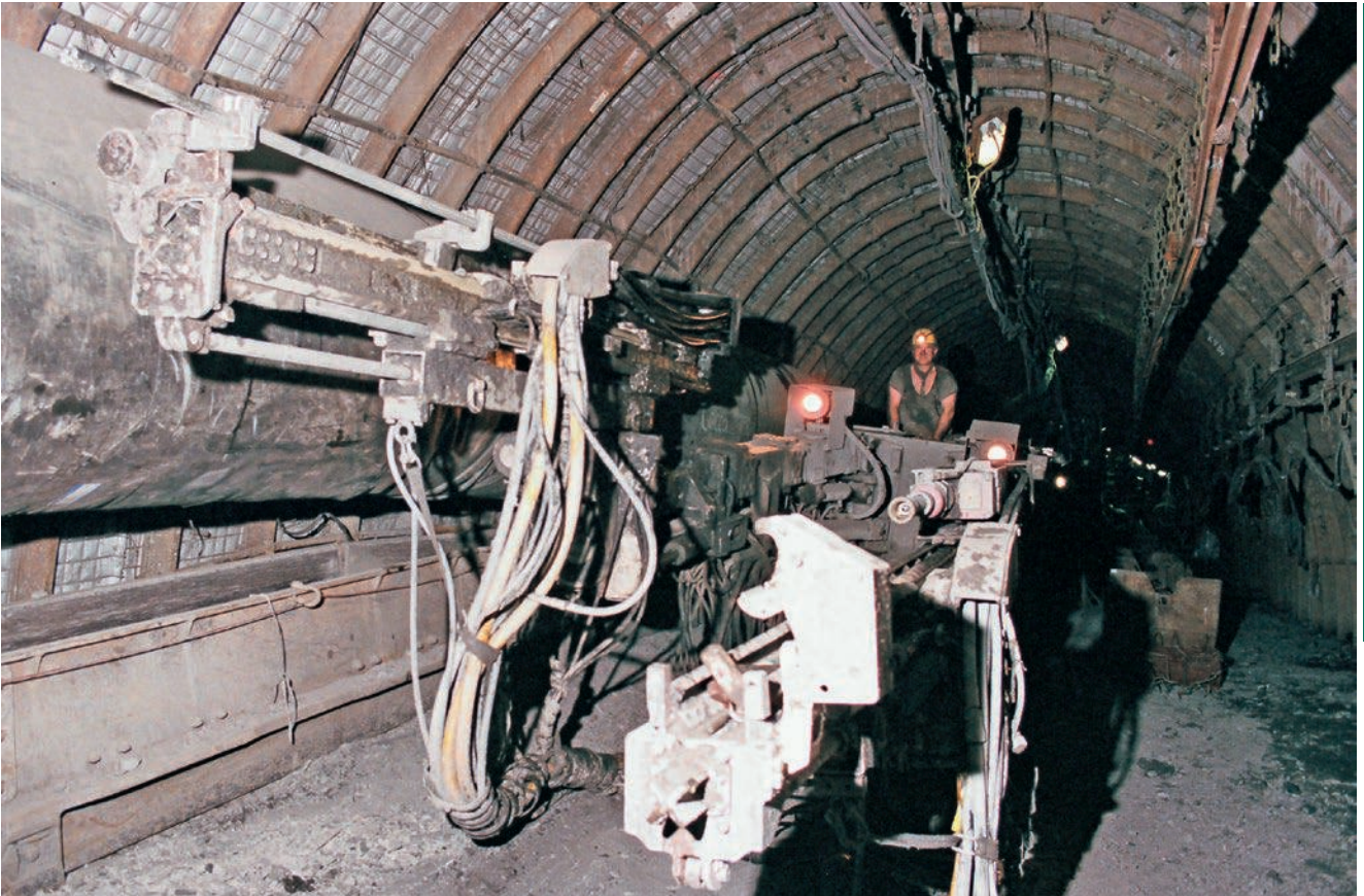
Bohrwagen BTRK – 2 erstellt Spreng- und Ankerbohrlöcher
