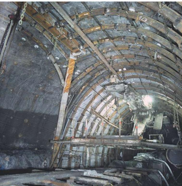
Nach dem Herstellen des Gebirgsausbruches und dem Einbringen der Gebirgssicherung, bestehend aus Anker und Drahtmattenverzug, wurde der Stahlprofilausbau komplett eingebaut und sofort mit Beton hinterfüllt.
