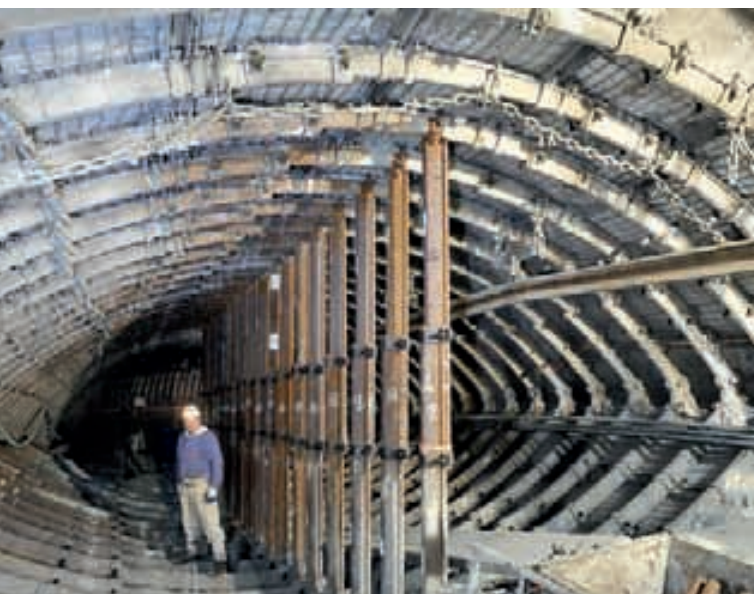
Stahlausbau Abschnitt I mit Verstärkung
