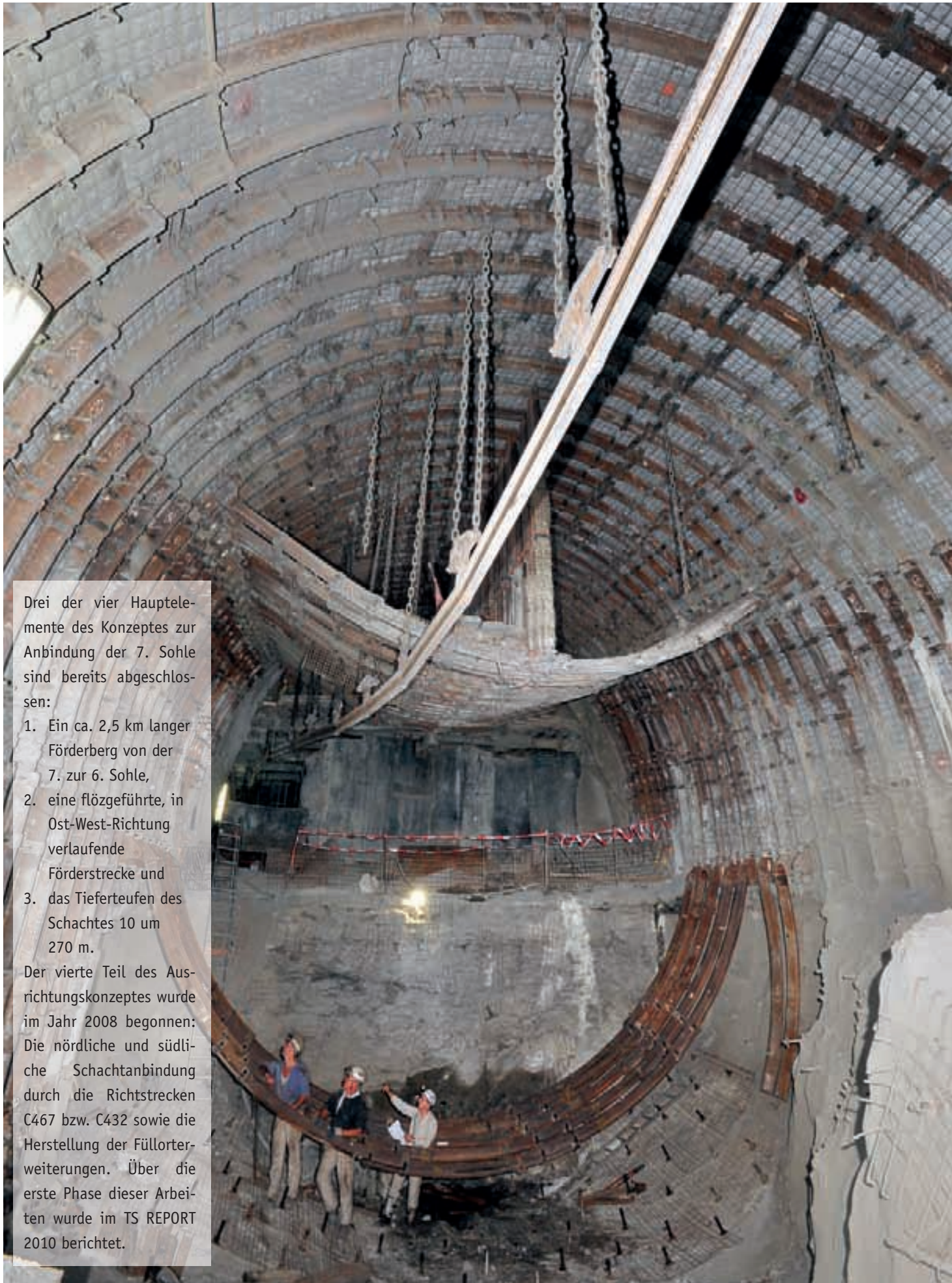
Montage der Sohlenschlüsse mit Systemankerung
