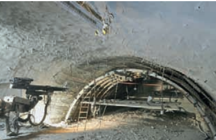
Beginn des Stahlausbaus im Firstbereich
