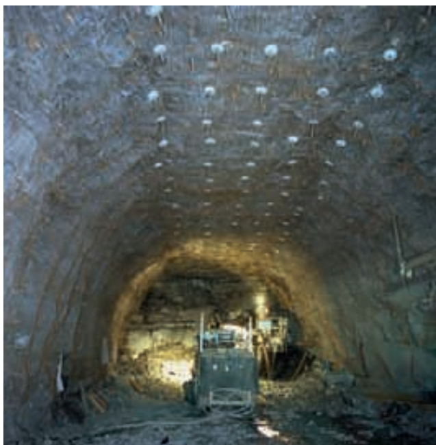
Auffahrung C432 im kombinierten Ausbau Typ A
