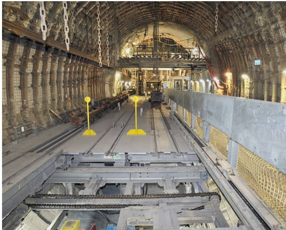
Südliches Füllort mit Gleisanlage
