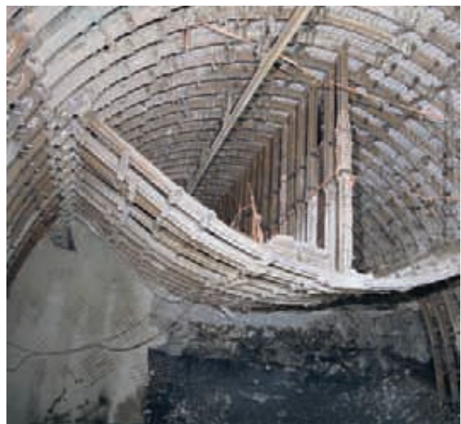
Auffahrung Abschnitt 2a und 2b
