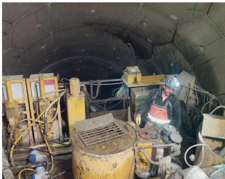
Тампонаж в наклонном стволе через железобетонные тюбинги
