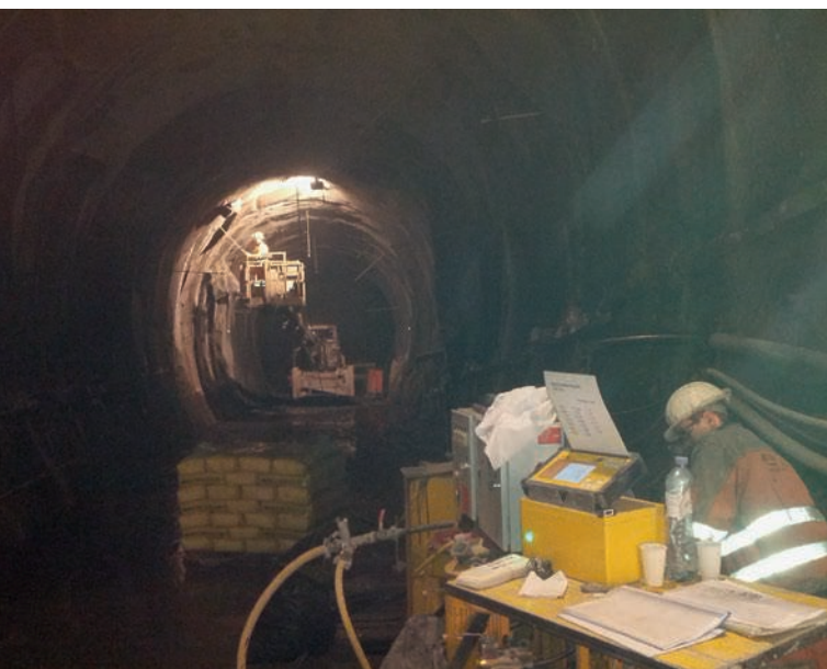
Документация тампонажа и тампонаж в гидротехническом туннеле
