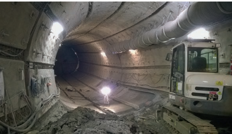
Выработка для размещения отходов Северная – углубление почвы с помощью проходческого экскаватора
