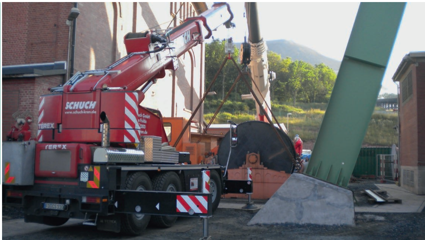
Перемещение и выверка 30ти-тонной лебедки с помощью пневматического подъемника, ствол «Нойхоф»
