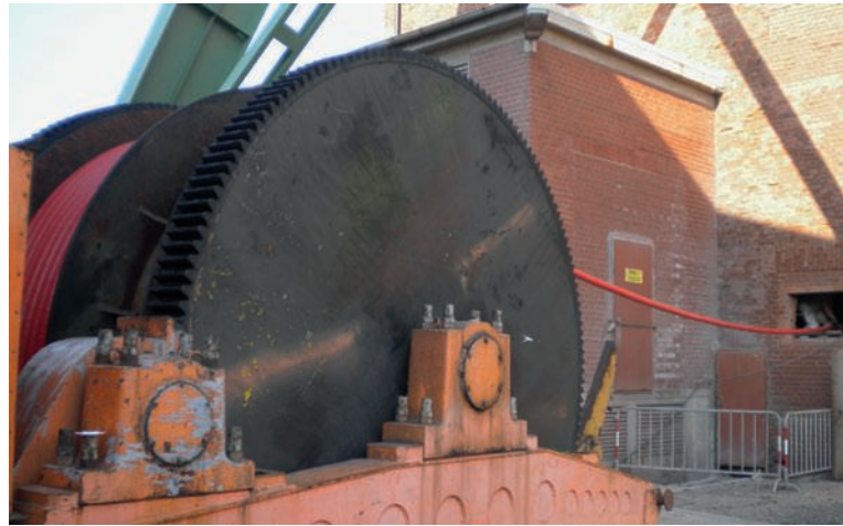
Монтаж кабеля 20 кВт, ствол «Нойхоф»
