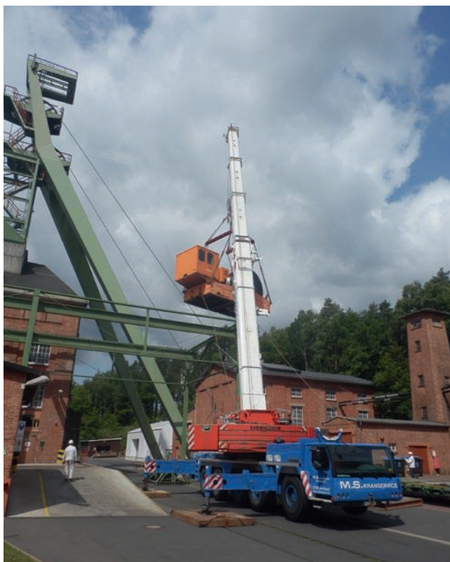
Транспортировка 30ти-тонной лебедки на ствол «Эллерс»
