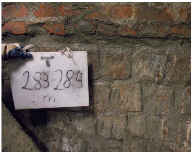
Очищенная каменная крепь шахтного ствола
