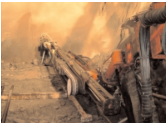
Bild oben links: Herstellen von Erkundungsbohrungen
