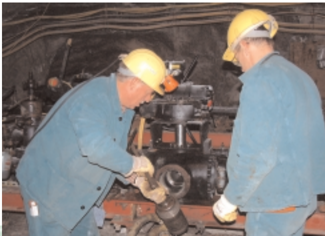
Arbeiten am Molchkugelhahn
