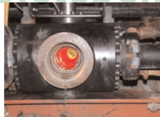
Bild rechts: Molchkugelhahn mit eingesetztem Molch
